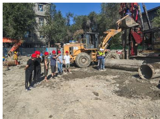
图 4-8 “金师”团队施工现场锻炼现场
