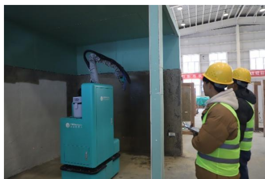
图 50 学生操作室内喷涂机器人实训
