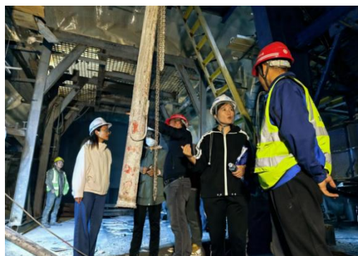
图 61 教师参观隧道施工现场
